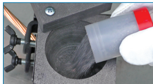
2 Pour weld metal into the mould crucible
